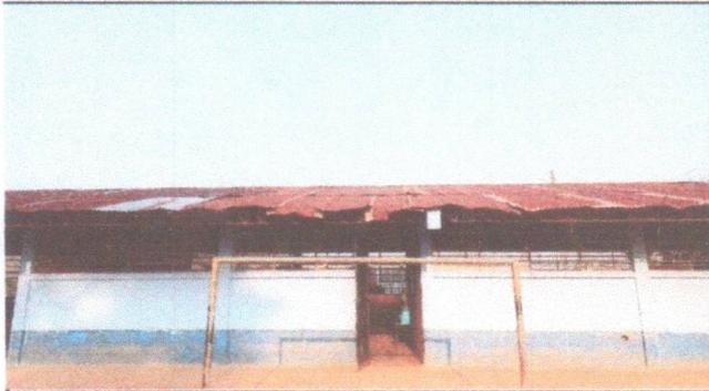
Foto1: SE OBSERVA LA NECESIDAD DE CAMBIAR LA CUBIERTA DE LAMINAS ACANALADAS YA DETERIORADAS.
