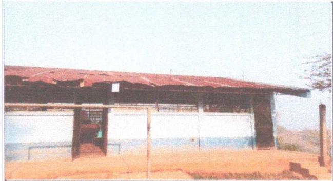
Foto 2: SE OBSERVA QUE LA ESTRUCTURA DEL TECHO NO ES LA ADECUADA PARA LAS LAMINAS.
