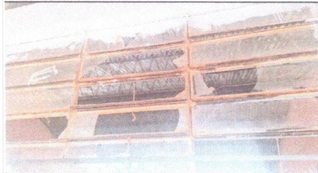
Foto 4: REPARACION DE VIDRIOS DE LAS VENTANAS QUEBRADAS
